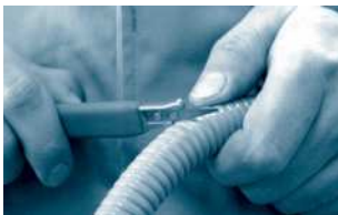
Schritt 1: Kunststoffmantel durchtrennen (falls vorhanden).
