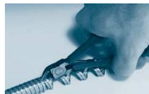
Schritt 3: Überstehendes Profil mit Bleischere oder Zange abtrennen.
