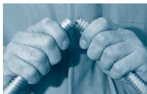
Schritt 2: Metallschlauch abknicken.
