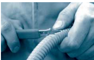
Schritt 1: Kunststoffmantel durchtrennen (falls vorhanden).
